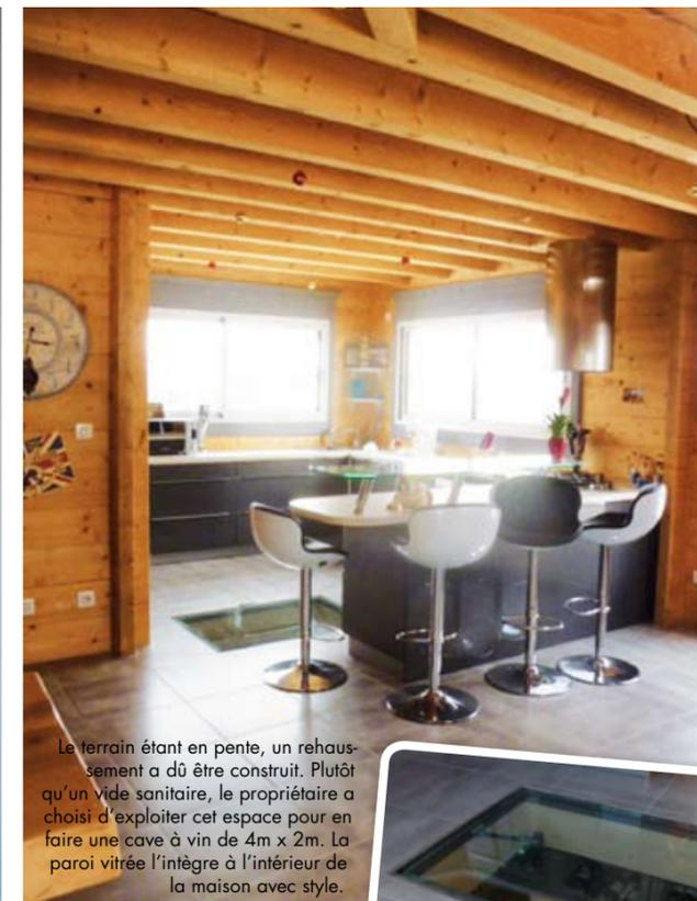
Le terrain étant en pente, un exhaussement a dû être construit. Plutôt qu'un vide sanitaire, le propriétaire a choisi d'exploiter cet espace pour en faire une cave à vin de 4m x 2m. La paroi vitrée l'intègre à l'intérieur de la maison avec style.
