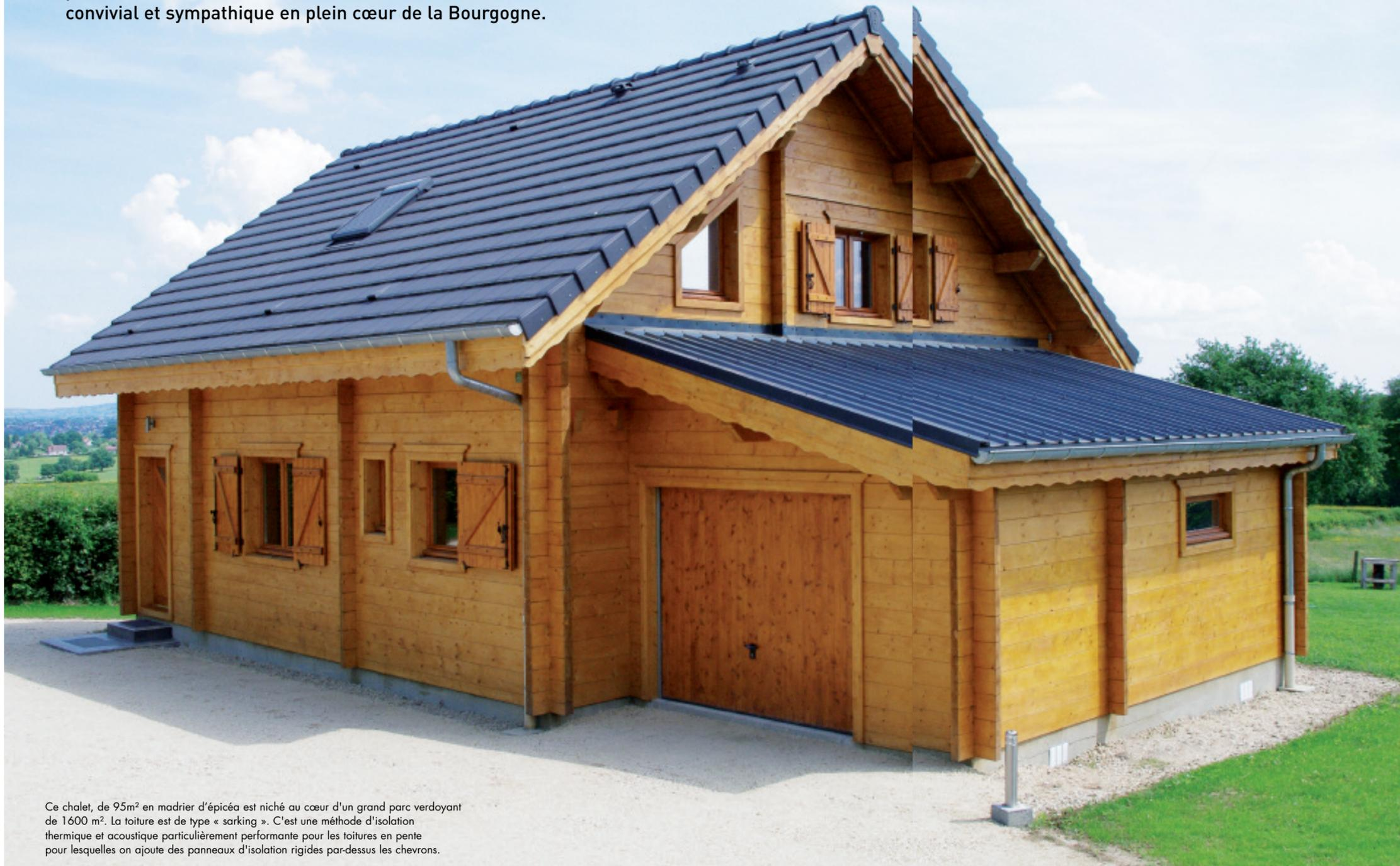
Ce chalet, de 95m<sup>2</sup> en madrier d'épicéa est niché au cœur d'un grand parc verdoyant de 1600 m<sup>2</sup>. La toiture est de type « sarking ». C'est une méthode d'isolation thermique et acoustique particulièrement performante pour les toitures en pente pour lesquelles on ajoute des panneaux d'isolation rigides par-dessus les chevrons.
