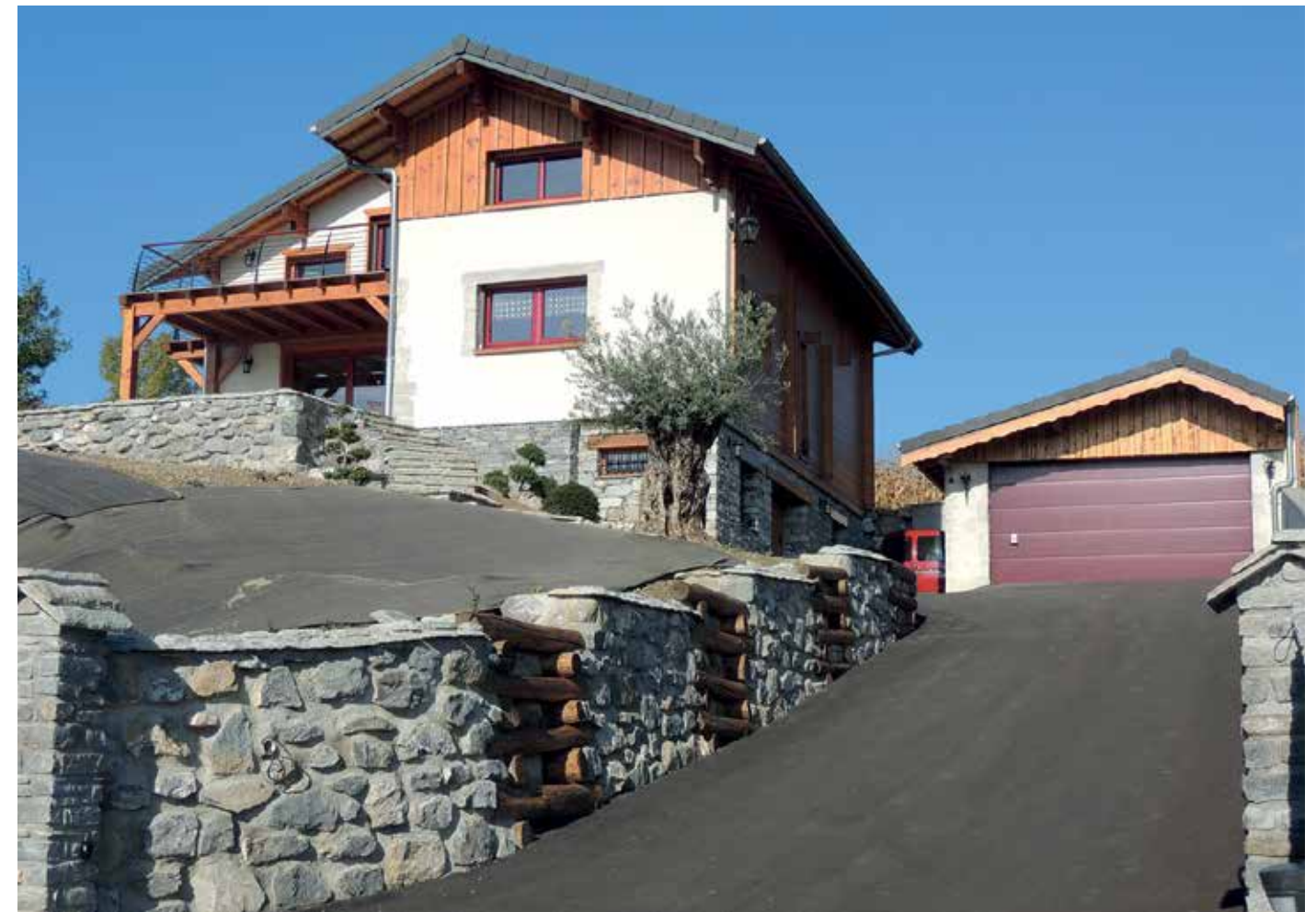
Des pierres de parement recouvrent les murs du rez-de-chaussée, tandis que de l'opus a été posé au sol.
